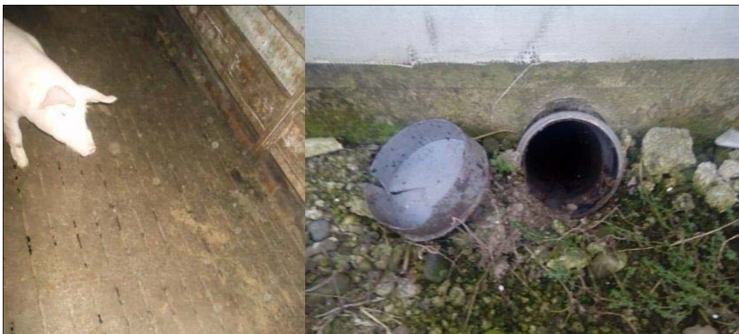
Slika 3 Rešetkasti pod i priključak za cisternu za pražnjenje gnojnice
